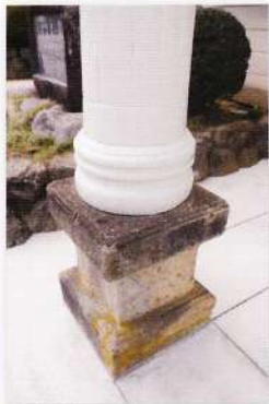
玄関柱下の凝灰岩製土台石 （青井石）
