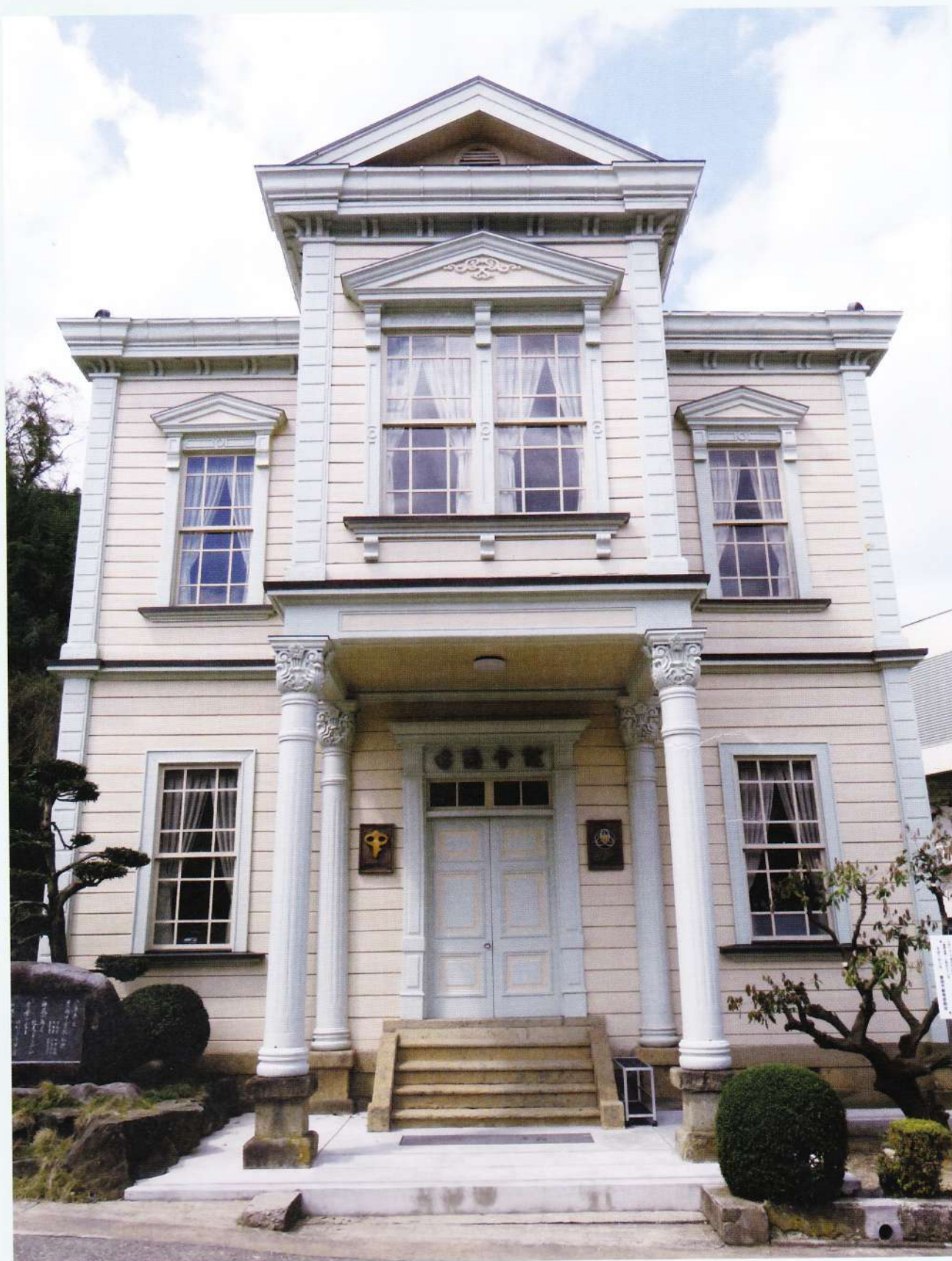
兵庫県指定重要有形文化財(建造物)
