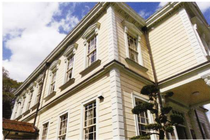
2階窓と三角ペディメント（西面）
